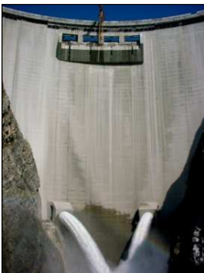
Le barrage hydroélectrique de Berke (Turquie)
