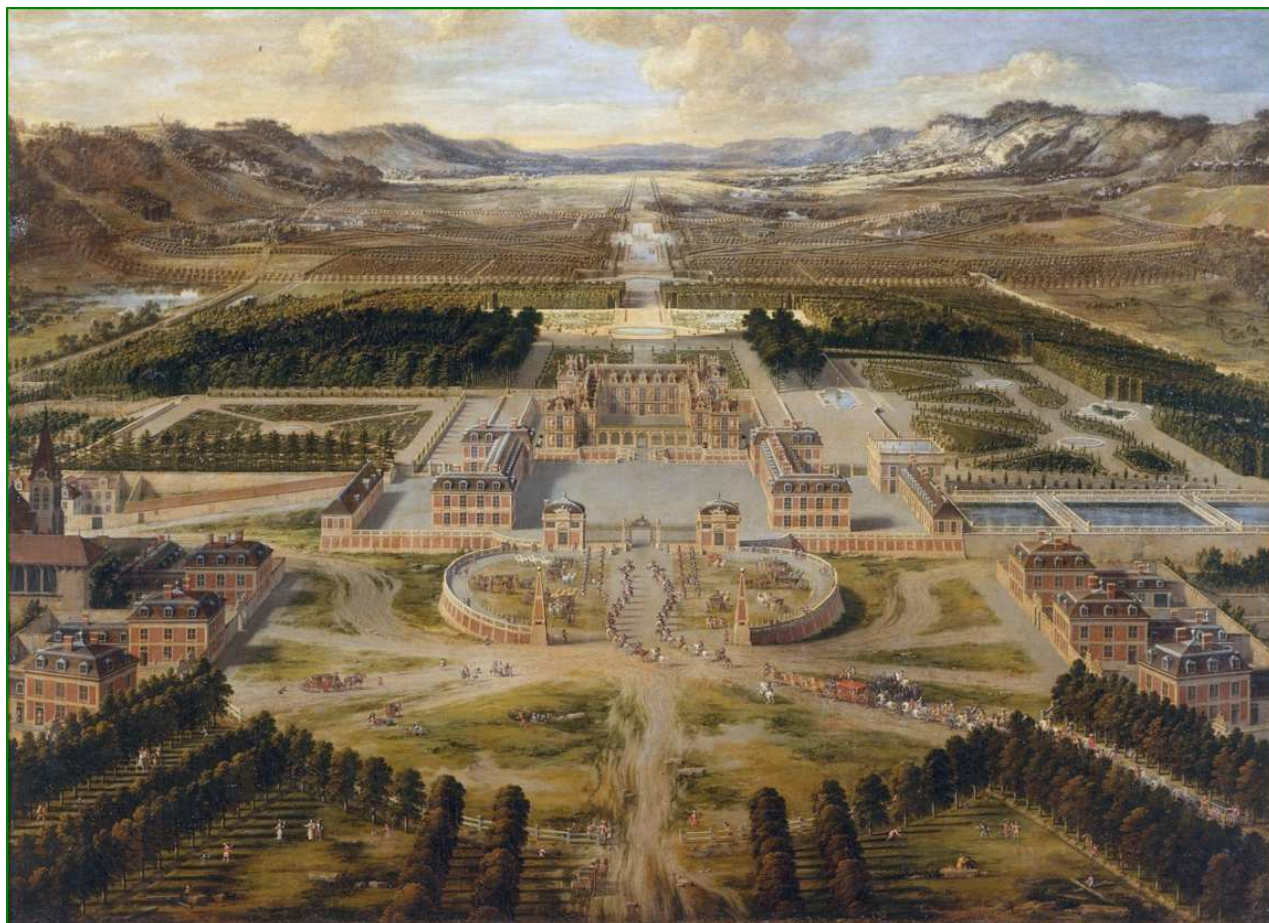
1662 - Les travaux ont bien avancé
