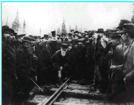
La construction du chemin de fer
